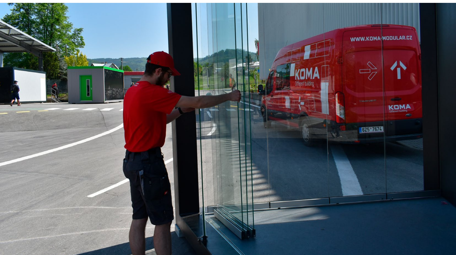
4. Krajní vytočený díl otočte zpět o 90 stupňů do stejné polohy, jako jsou ostatní díly a umístěte tento díl před ostatní díly. Zaaretujte proti posunu otočením aretačního kolíku do svislé polohy
