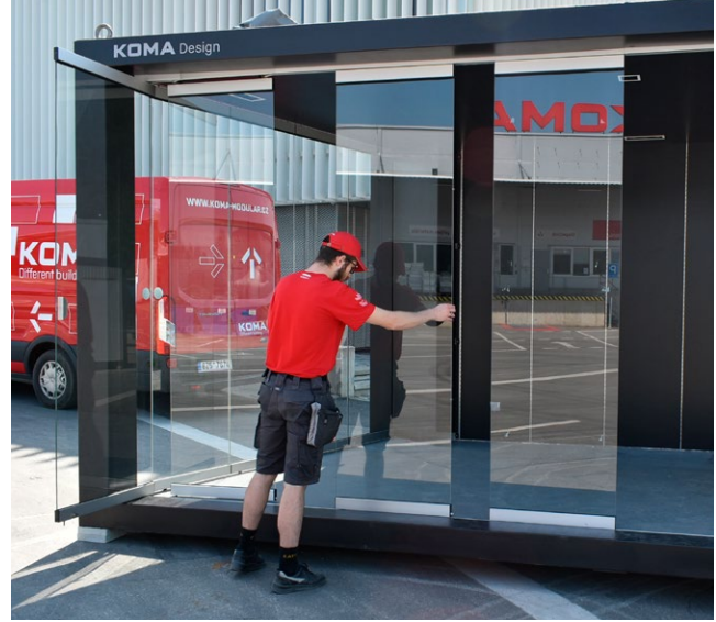
3. Odjistěte aretaci na dalším dílu (z vnitřní strany) a postupně pře- suňte na stranu 3 další díly
