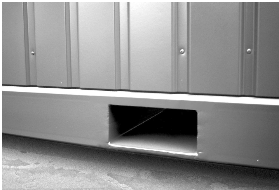
Obr. 13 Manipulační otvory pro použití vysokozvižného vozíku
