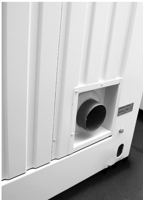
Obr. 11 Přívod vody a vyvedení kanalizace boční stěnou modulu
