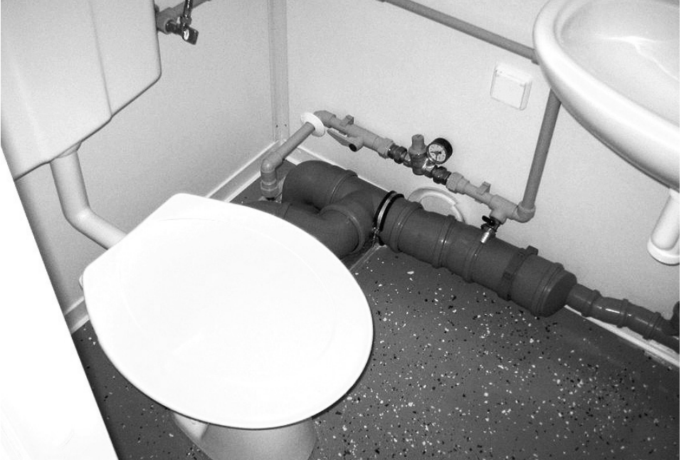
Bild 12 Installation im Boden
