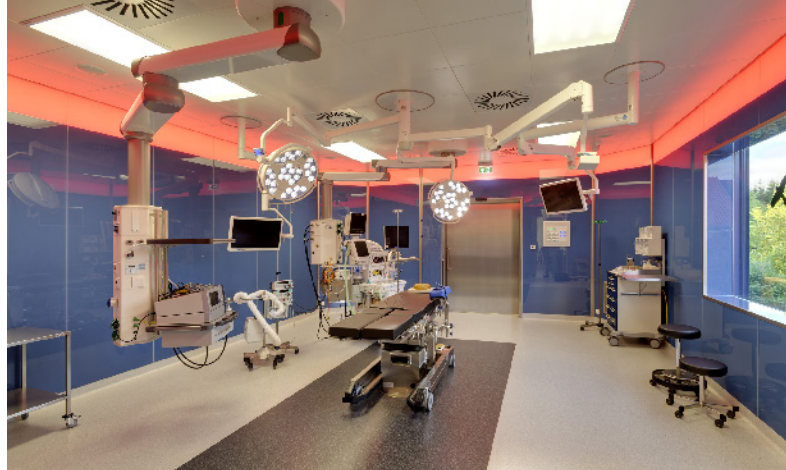
▲ Obr. 2 Operační sál v modulární klinice Ammerland Klinik © Cadolto
