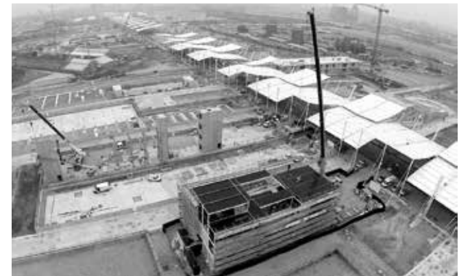
Staveniště v říjnu 2014, po dokončení hrubé stavby.
