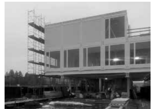
Osazování výplní otvorů, listopad 2014.
