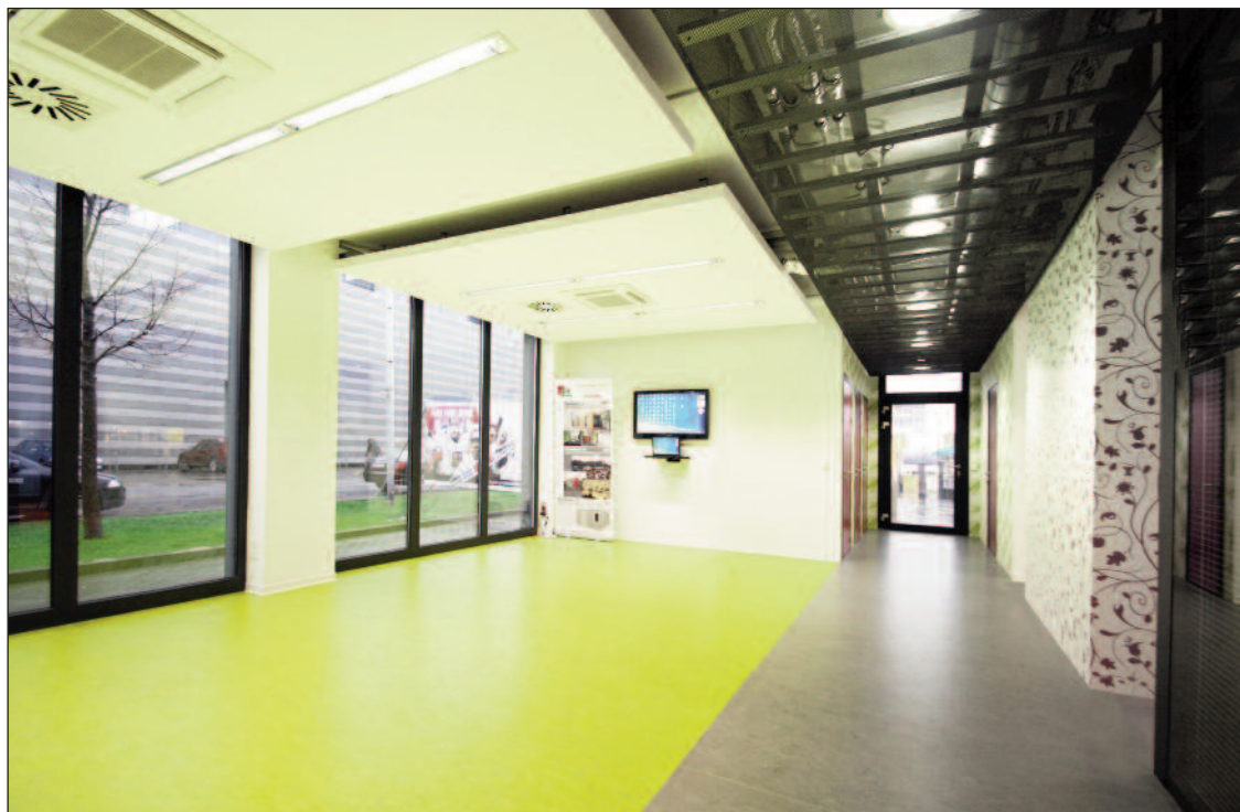
■ Interiér tvoří sádrovláknité desky s různými povrchovými úpravami.
