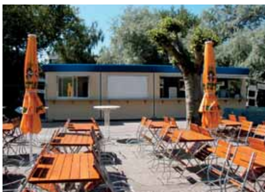
Restaurace Brauerei Nette v německém Aldernachu je postavená u Labe na speciální pohyblivé rampě, která se pohybuje v závislosti na výšce hladiny vody (dodavatel Koma Modular Construction, s. r. o.).
