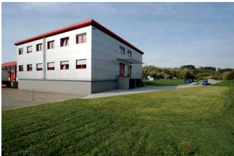
Kancelářská budova s alucobondovou fasádou postavená technologií modulární výstavby a její interiér (dodavatel Koma Modular Construction, s. r. o.)
