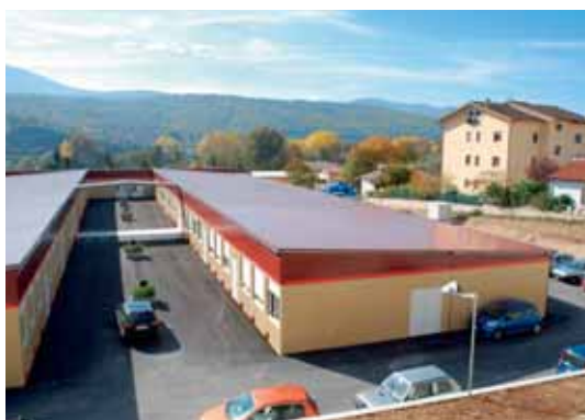
Škola se 22 třídami do města L'Aquila postiženého zemětřesením byla vyrobena, dodána a smontována z modulů za 7 týdnů (dodavatel Koma Modular Construction, s. r. o.).
