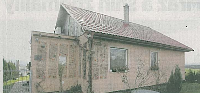
Dům z modulů Ve Slušovicích stojí dům z modulů, který vyrostl za pouhé tři dny. Na první pohled nepoznáte, že není stavěn klasickou technologií.
