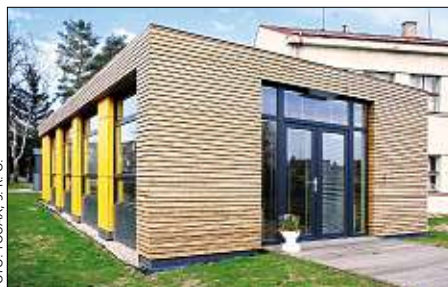
Celkový pohled na novou modulovou mateřskou školu v Poříčanech (okr. Kolín).
