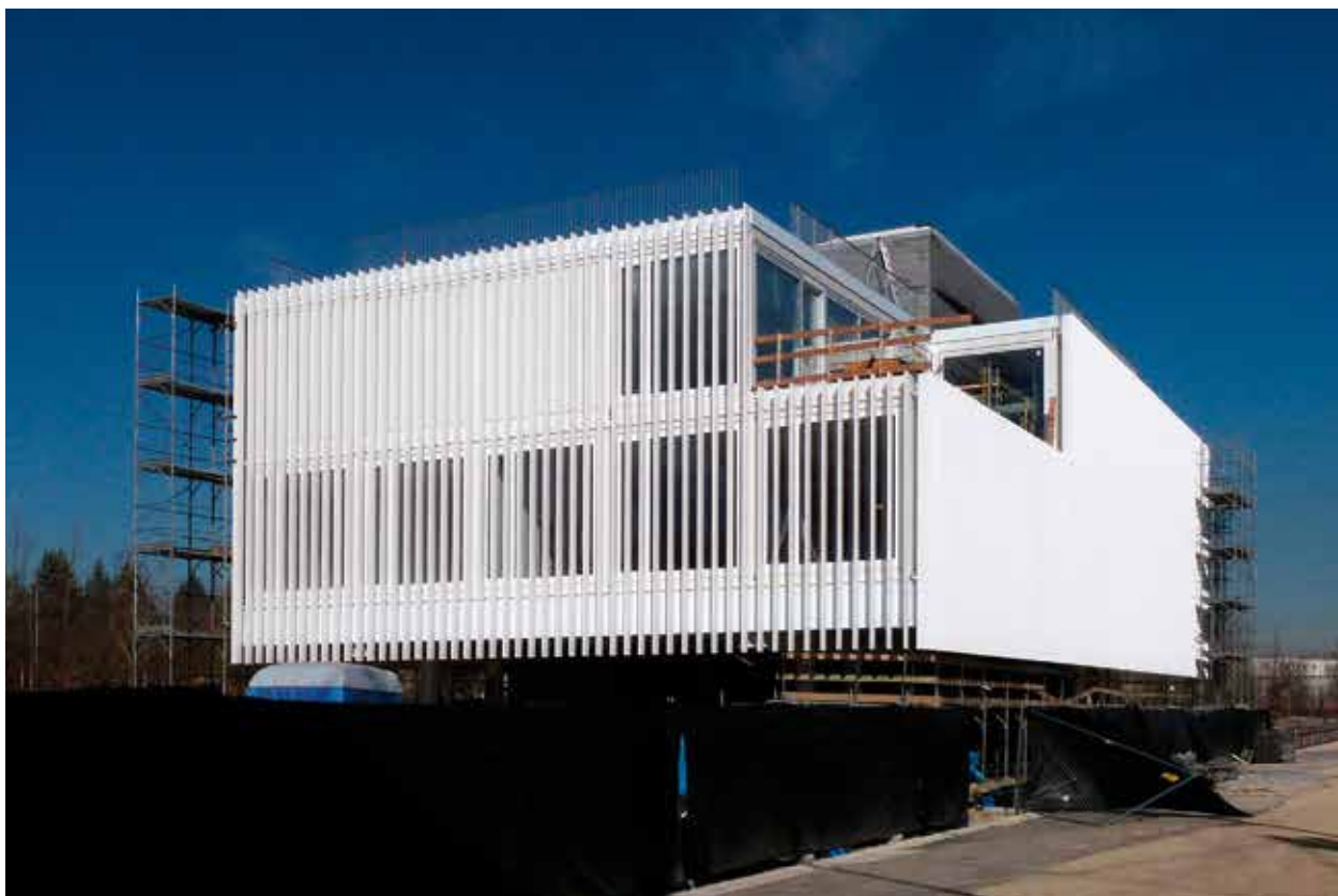
Pavilon na přelomu ledna a února 2015; svislé stínící elementy slouží současně jako hlavní vizuální prvek fasády; zdroj: KOMA Modular.
