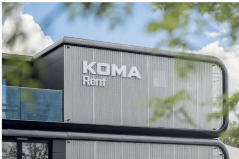
Pražská pobočka KOMA Modular se zaměřením na pronájem si postavila sídlo z modulů typové série Fashion Line Office; řada Fashion Line získala v loňském roce ocenění Red Dot v kategorii Produktový design.
