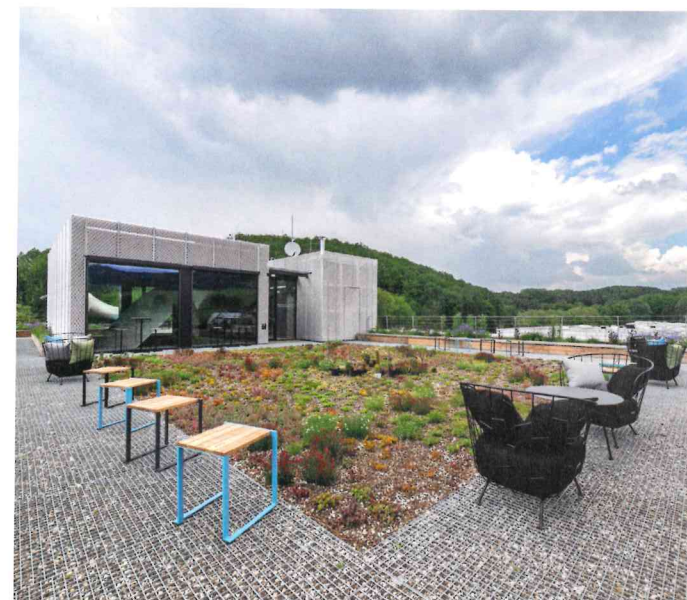
Budova nyní slouží jako administrativní a výstavní centrum, zahrada na střeše jako klidová a prezentační zóna firmy. Řešení přibližuje možnosti uplatnění zelených střech i na lehkých montovaných objektech.
